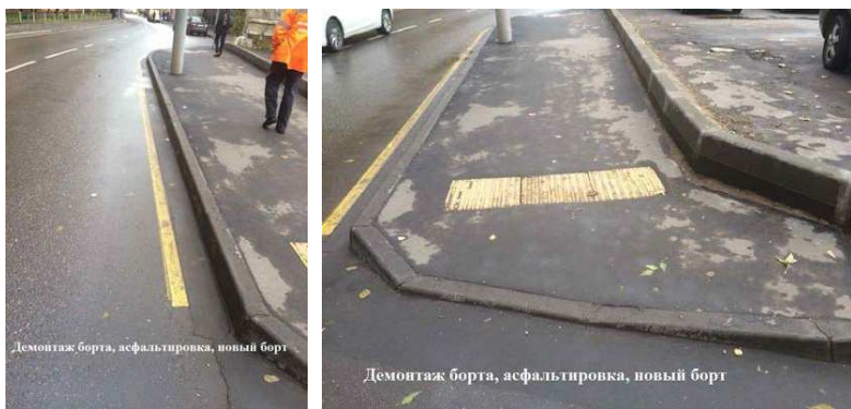
Демонтаж борта, асфальтировка, новый борт
